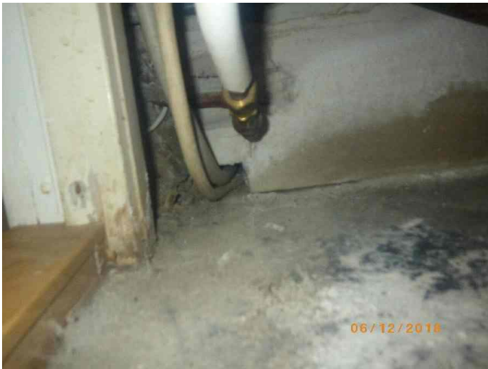
Personalrum : Otätheter kring röranslutning, det drar kraftigt från otätheter
